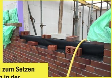
**DIN-konforme Lösung zum Setzen von Luftschichtankern in der Abdichtungsebene**
