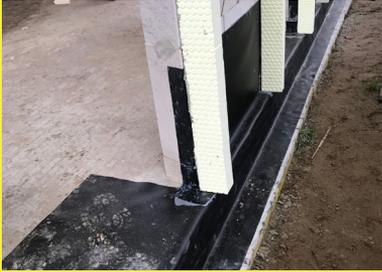
**DIN-konforme Abdichtung bodentiefer Fenster mit Kombi-Ecke von außen**
