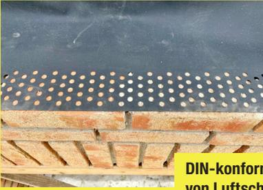
**Rollschichtfolie inklusive einseitigem Klebstreifen zur Fixierung der Bahn am Fenster**
