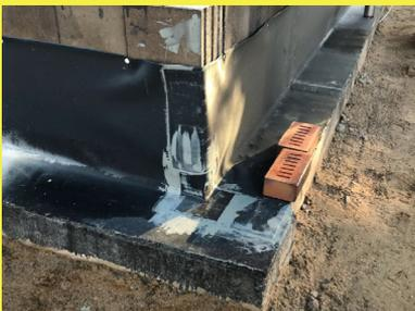
Druckwasserdichtes Formteil „Innenecke“
